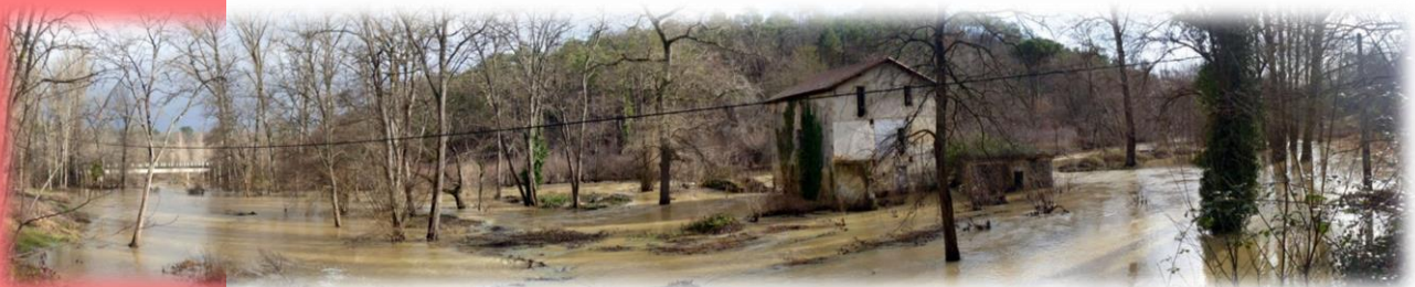
Figure 4: Champ d'expansion de crue fonctionnel (Mlin de Peyré)
