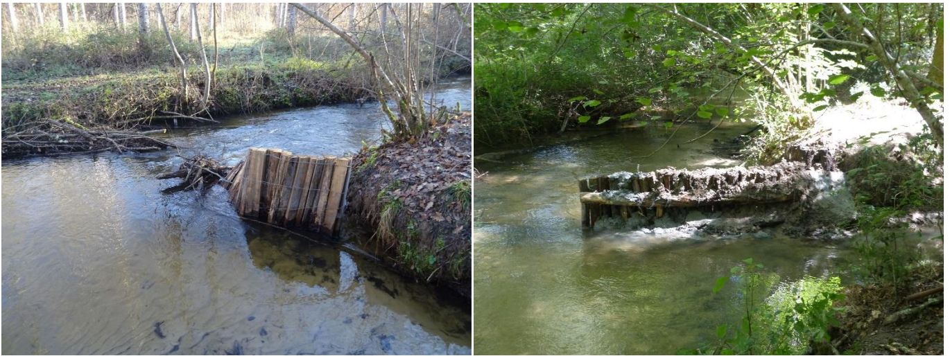
Figure 6 : photos avant/après – restauration de l'épi dans le cadre du contrat Natura 2000 déposé en 2019 Commune de Sos-Gueyze-Meylan
